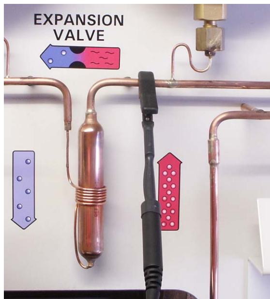
Fig. 1: Temperaturmessung vor dem Expansionsventil der Wärmepumpe
