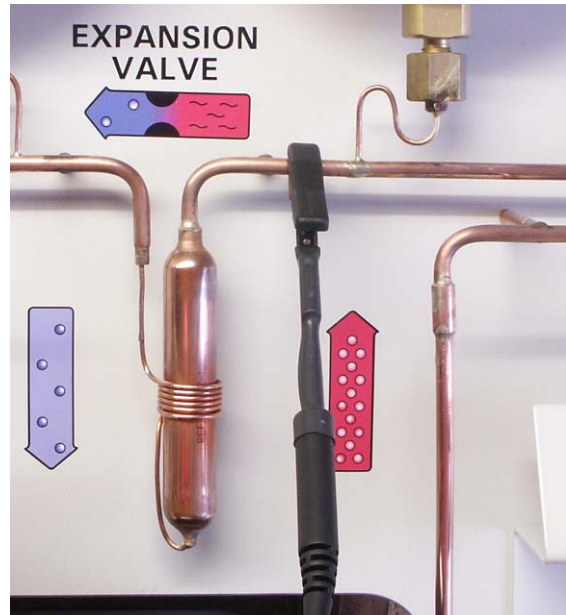
Fig. 1: Medición de la temperatura antes de la válvula de expansión de la bomba de calor
